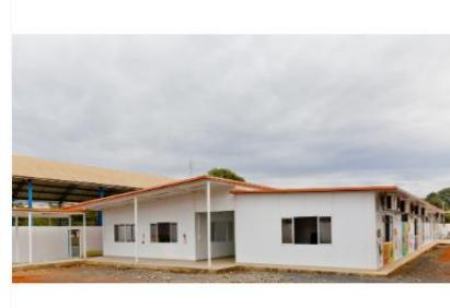
**Sistema Construtivo Modular**Ampliação de 664,37m<sup>2</sup> em 150 dias.
